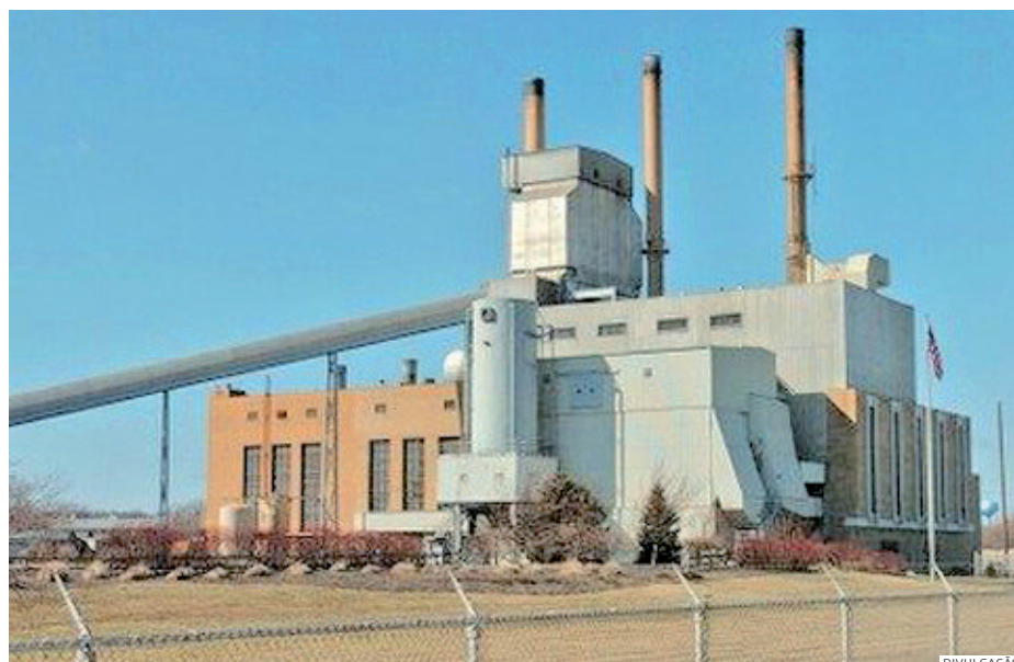
Termelétrica James de Young Power, instalada na Holanda, um dos países onde se buscou experiências para projeto de São José
