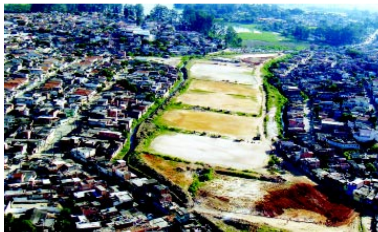
Assoreamentos transformados em campos de futebol
